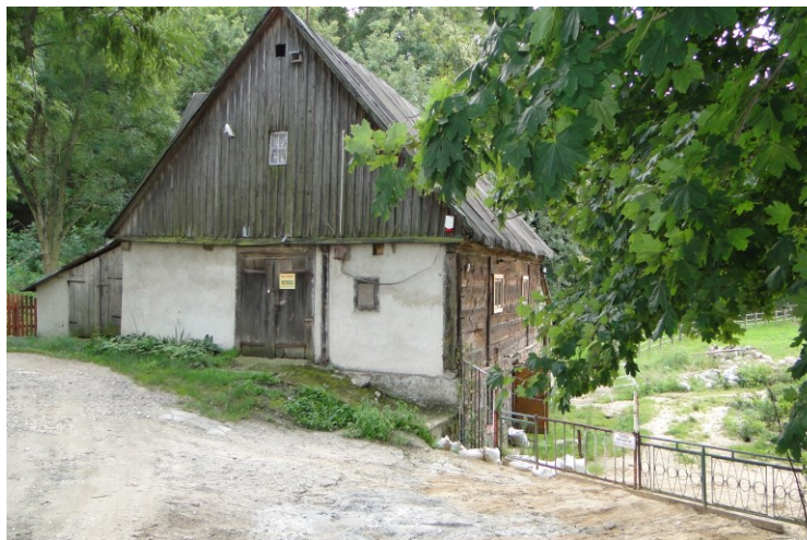
Widok budynku od północy
