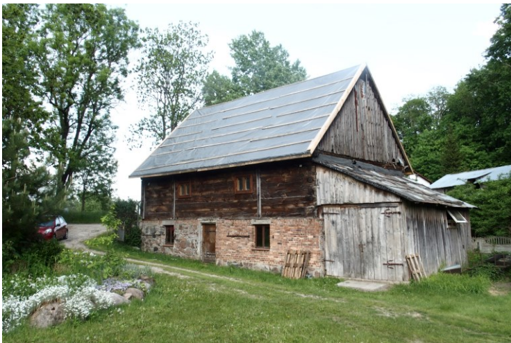
Widok budynku od południowo-zachodu
