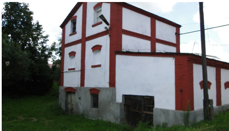
Widok budynku od północnego-wschodu
