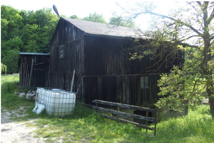
Widok budynku od północnego-wschodu
